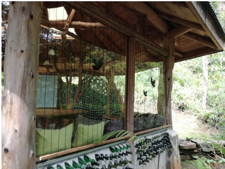
Figura 5. Edificación con grandes ventanales que presentan siluetas y cuerdas para prevenir las colisiones de aves, Monteverde, Costa Rica
